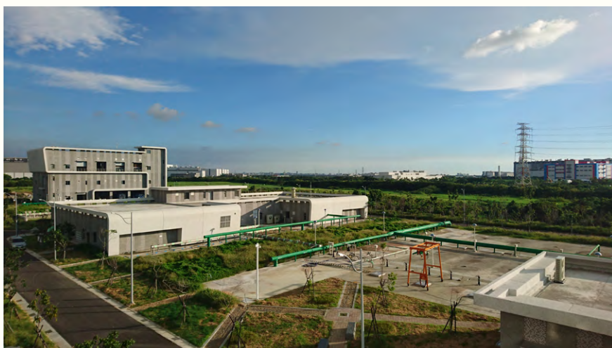
調節池及污泥處理大樓
