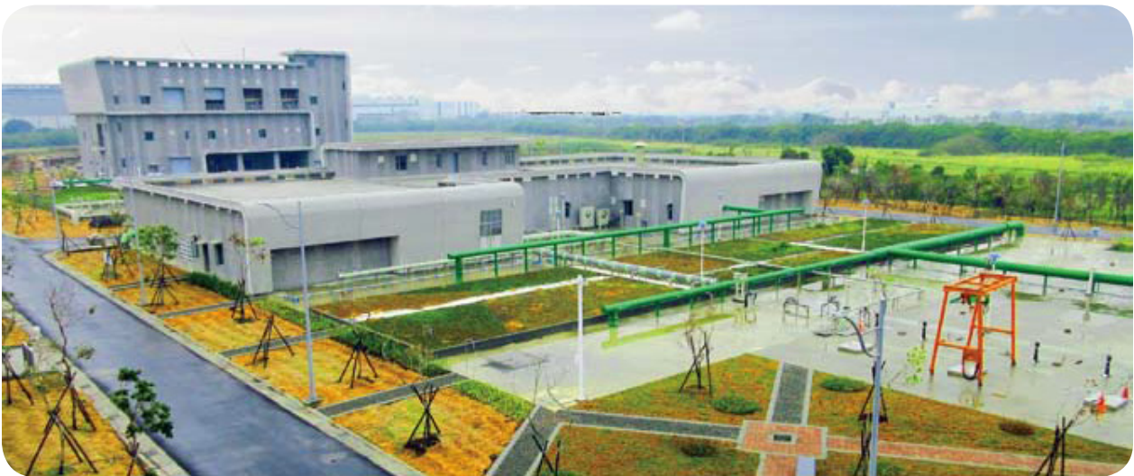
調節池及污泥處理大樓
