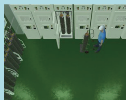
鋼瓶安裝畫面
