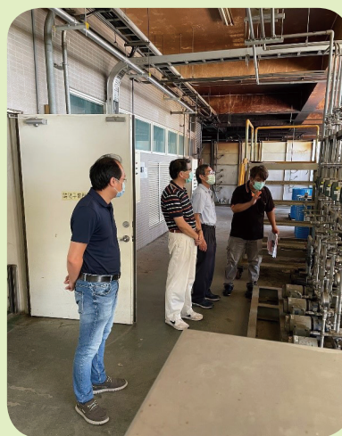
新揚科技訪廠
